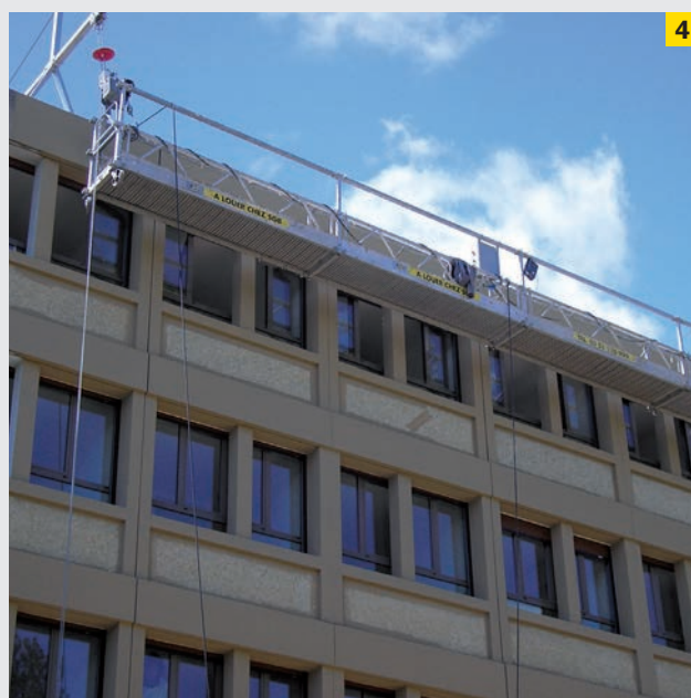
3 Plate-forme offrant de multiples possibilités. 4 Exemple de plate-forme suspendue longueur 12 mètres.
