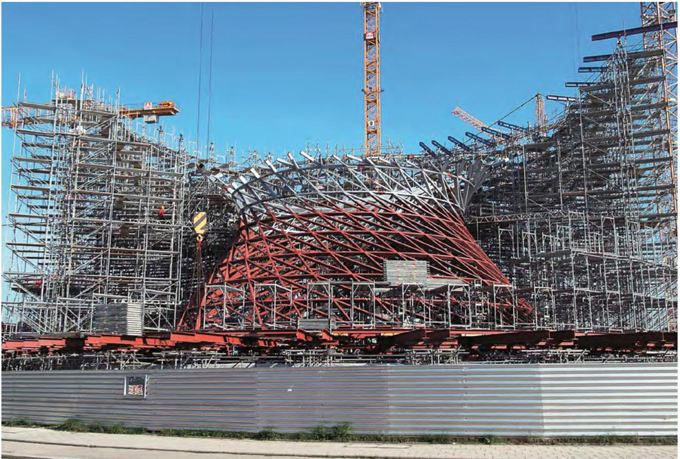
► BOSTA 70 ist mit MODEX einsetzbar. Hier ist es in Kombination zu einem sternförmigen Korsett kombiniert, das dazu diente, die hohen Lasten abzutragen
