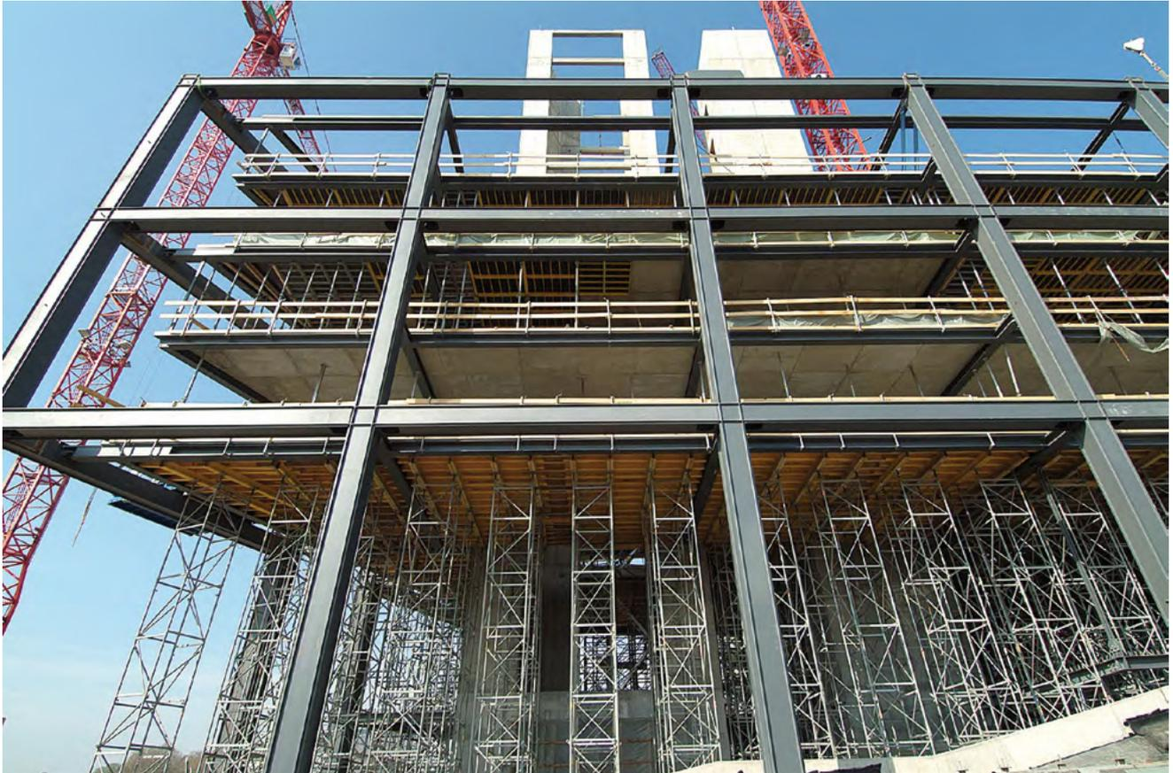
▶ Hohe Tragfähigkeit von 180 kN pro Turm trotz kleinster Basisabmessungen von nur 1,0 x 1,0 m
