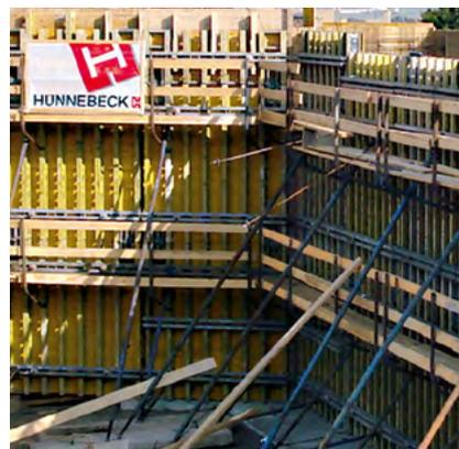
► Betondruckaufnahme bis zu  $80 \text{ kN/m}^2$  möglich
