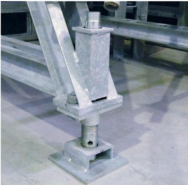
▶ Eingebaute Fußspindeln ermöglichen die präzise Ausrichtung der einhäuptigen Konstruktion
