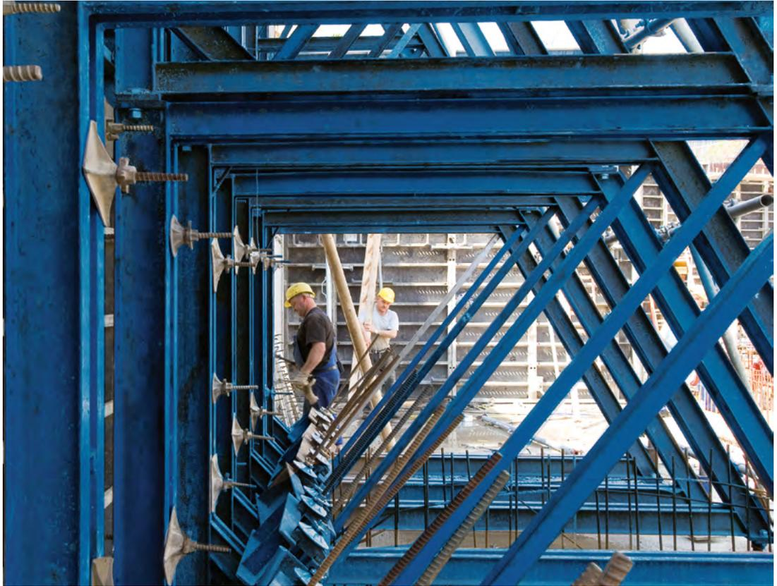
▶ Hohe Festigkeit: Stützböcke halten einem maximalen Betondruck von bis zu 60 kN/m<sup>2</sup> stand
