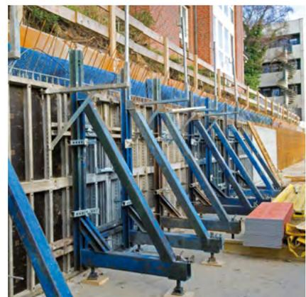
► Die Abstände zwischen den Stützböcken können je nach Bauplan angepasst werden
