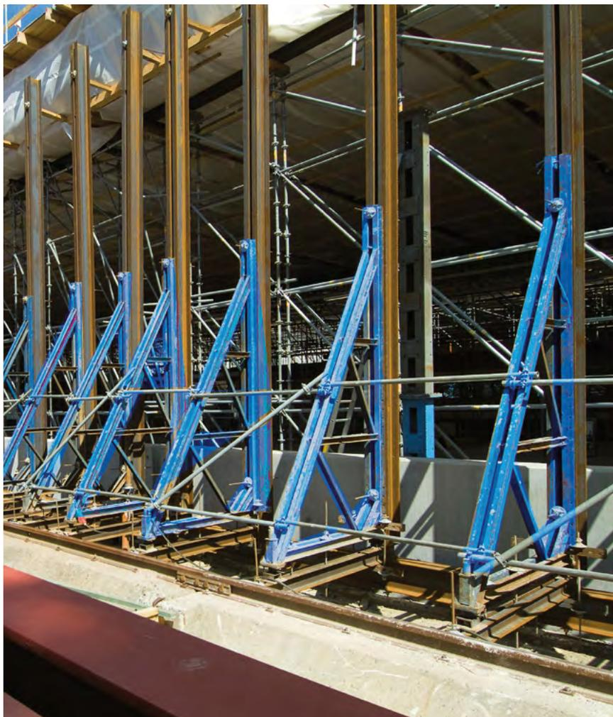
◀ Stützböcke können auch in einer Spezialanwendung zur Stabilisierung von MODEX Gerüsten gegenüber horizontalen Kräften verwendet werden.
