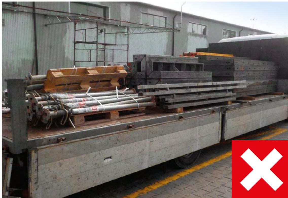
**Abbildung 10** Fehlerhaft vorbereiteter Transport: Die EUROPLUSnew Stahlrohrstützen liegen lose und sind nicht in Euro-Stapelgestellen verladen. Außerdem sind die Schalungspakete nicht gebündelt.
