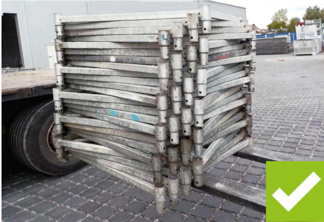
**Abbildung 5** Sicheres Stapeln von ID15 Endrahmen.
