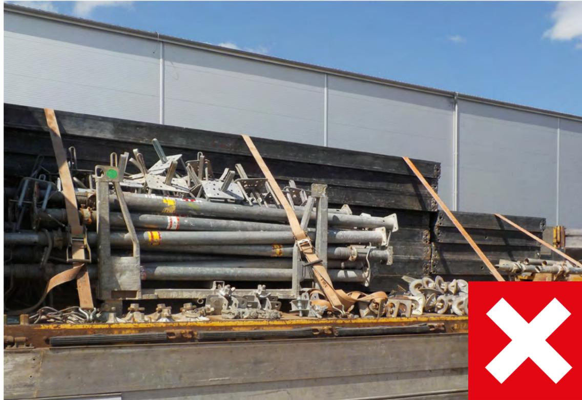
**Abbildung 9** Unsicher vorbereiteter Transport: Lose Zubehörteile wurden nicht in Euro-Gitterboxen verladen und können bei Fahrtantritt herunterfallen.
