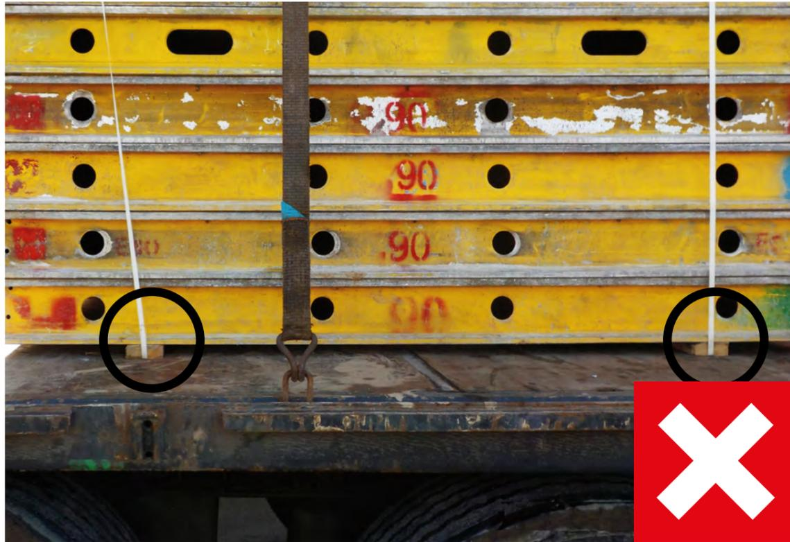
**Abbildung 13** Falsch vorbereiteter Transport: Die Unterleggehölzer sind zu niedrig, sodass ein Gabelstapler zum Entladen nicht darunter greifen kann.
