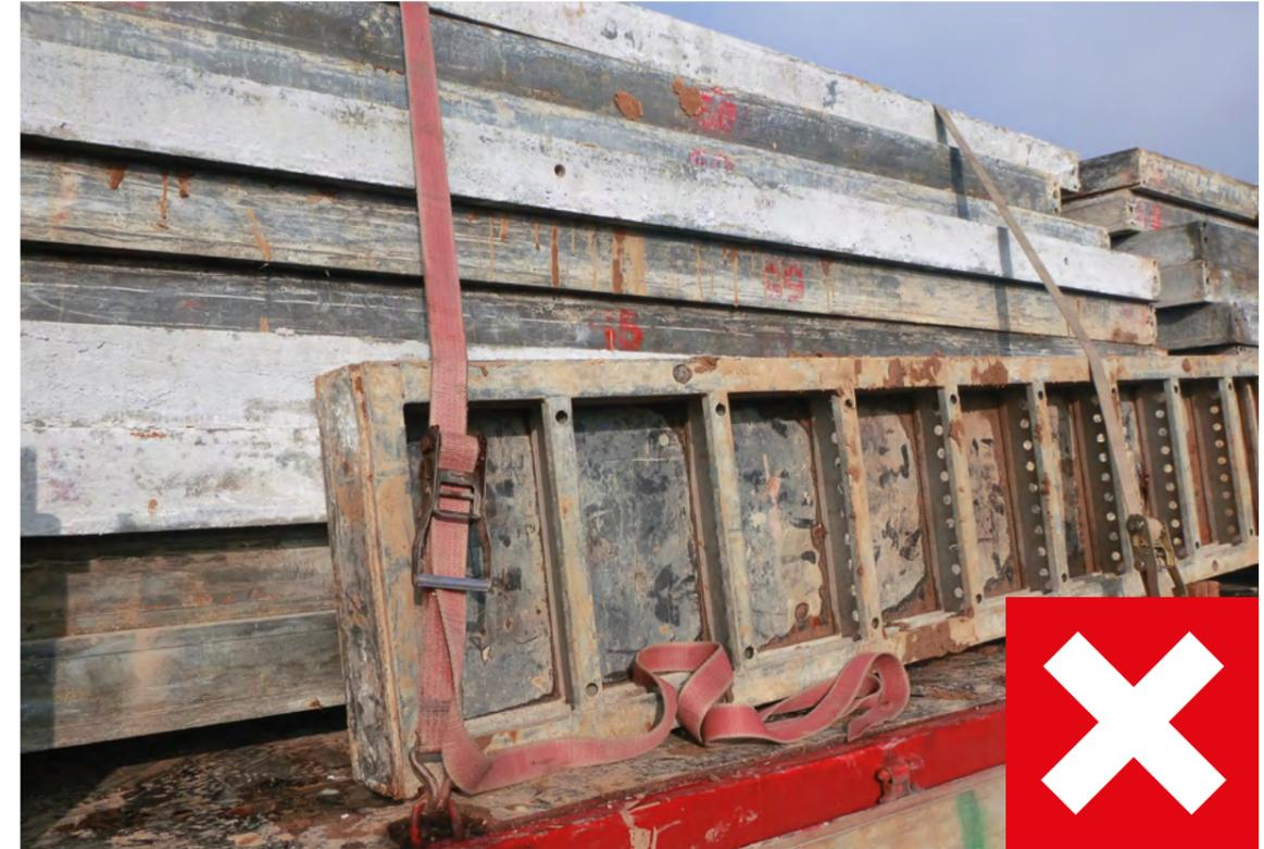
**Abbildung 11** Die Transportrichtlinien wurden nicht eingehalten. Die Schalungspakete sind ungebündelt und lose abgestellt.
