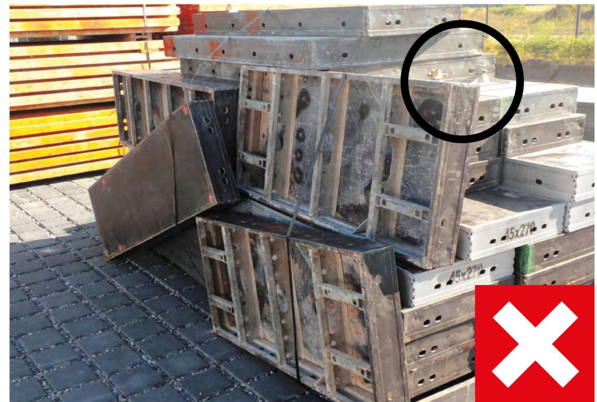
**Abbildung 16** Falsche Materialbündelung: Unterschiedliche Größen von RASTO und TAKKO Tafeln wurden senkrecht und waagrecht ineinander gestapelt. Zusätzlich befinden sich lose Zubehörteile auf der Schalung.
