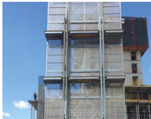
► Schutz mehrerer Etagen durch optionale vertikale Verlängerung
