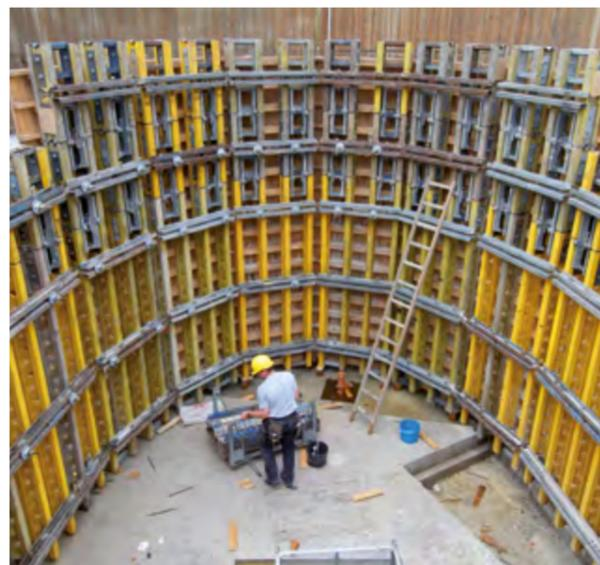
► Gewünschte Elementhöhen können problemlos je nach Sichtbetonanforderung ausgeführt werden
