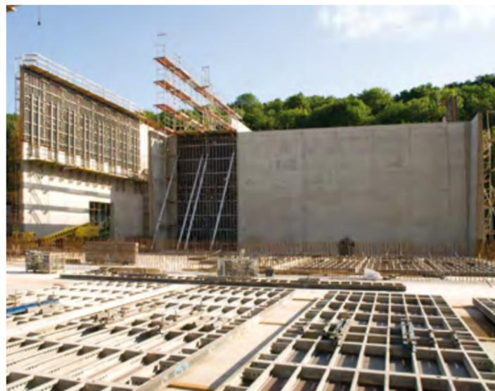
► Durch die Verwendung von Fassadenriegeln wurden die 16,73 m hohen Wände eines Terminals in zwei statt drei Betonierzyklen geschalt
