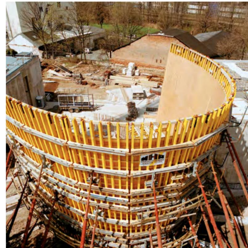
► Gewünschte Elementhöhen können je nach Sichtbetonanforderung ausgeführt werden
