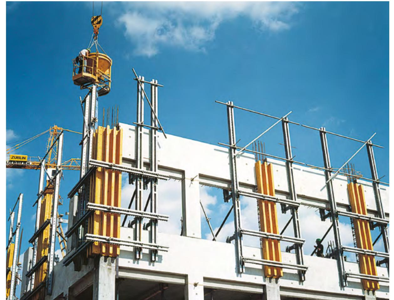
► Die Fassadenschalung ermöglicht die effiziente Herstellung von Fassaden mit Betonfertigteilen und Ortbetonstützen
