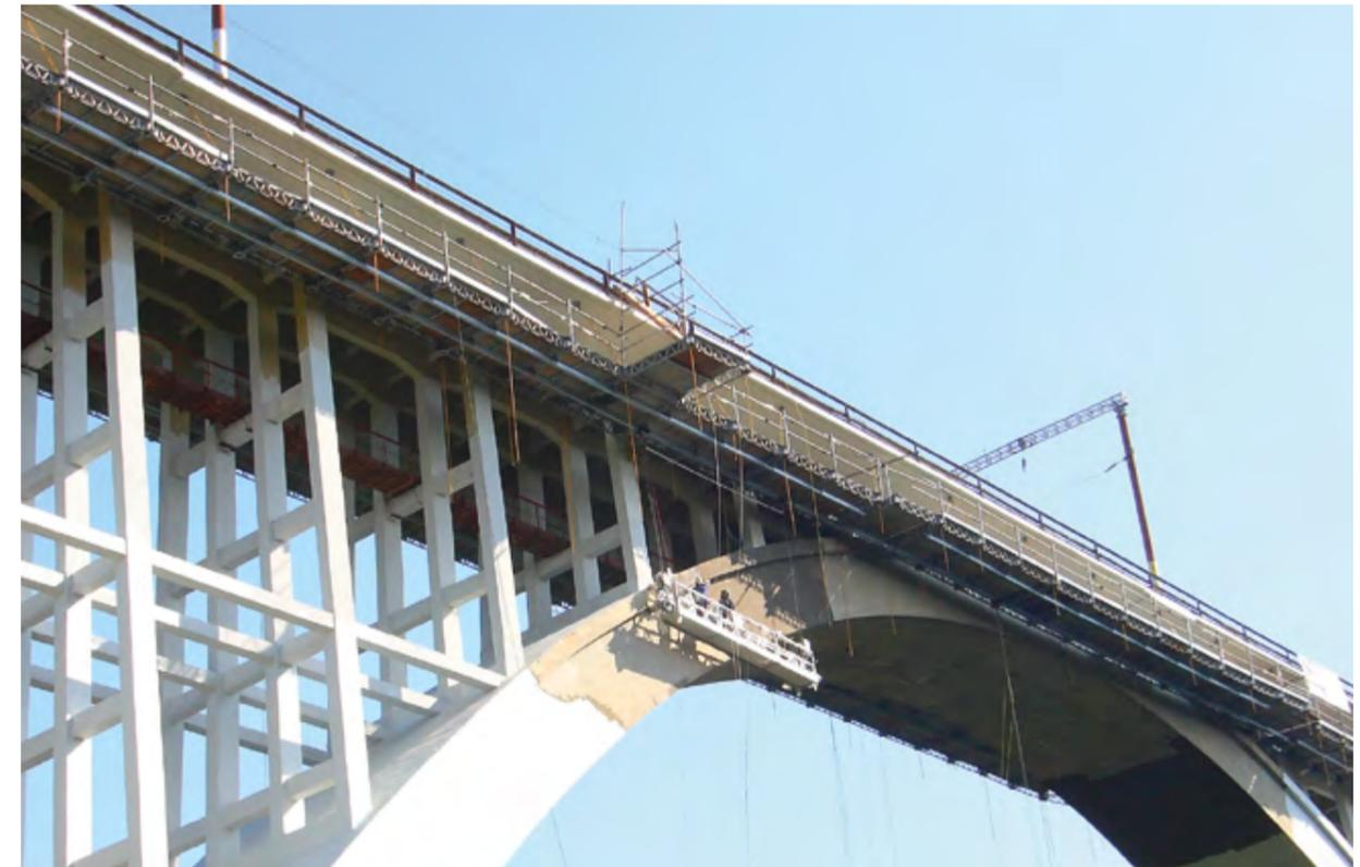
► Die an der rumänischen Eisenbahnbrücke Caracău Viaduct abgehängten QuikDeck Plattformen bieten eine durchgängige, sichere Arbeitsebene und ersetzen ein klassisches Raumgerüst. Das senkt die Kosten der Brückenerneuerung und beschleunigt sie
