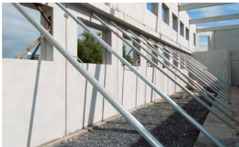
► Gutes Tragkraft-Eigengewicht-Verhältnis mit fünf Strebentypen mit Auszugslängen von 2,05 – 10,25 m
