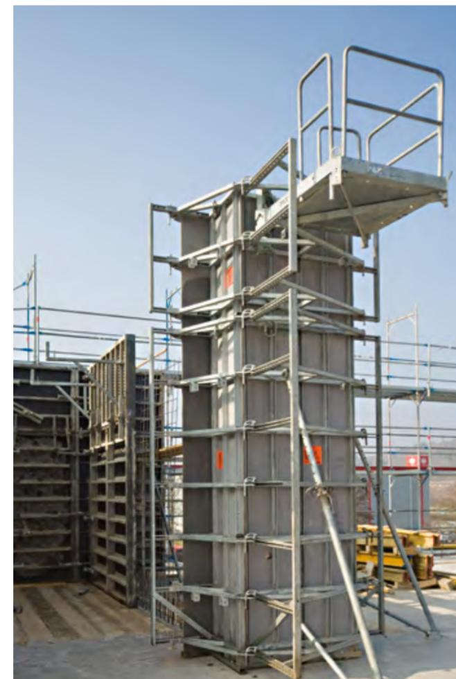
◀ Montierte Säulenschalung mit Betonierbühne in einer Einheit zum sicheren Betoneinbau. An einer Seite der Betonierplattform kann das Anbauset für Steigleitern angebracht werden, das das Einhängen und Sichern einer Leiter ermöglicht.
