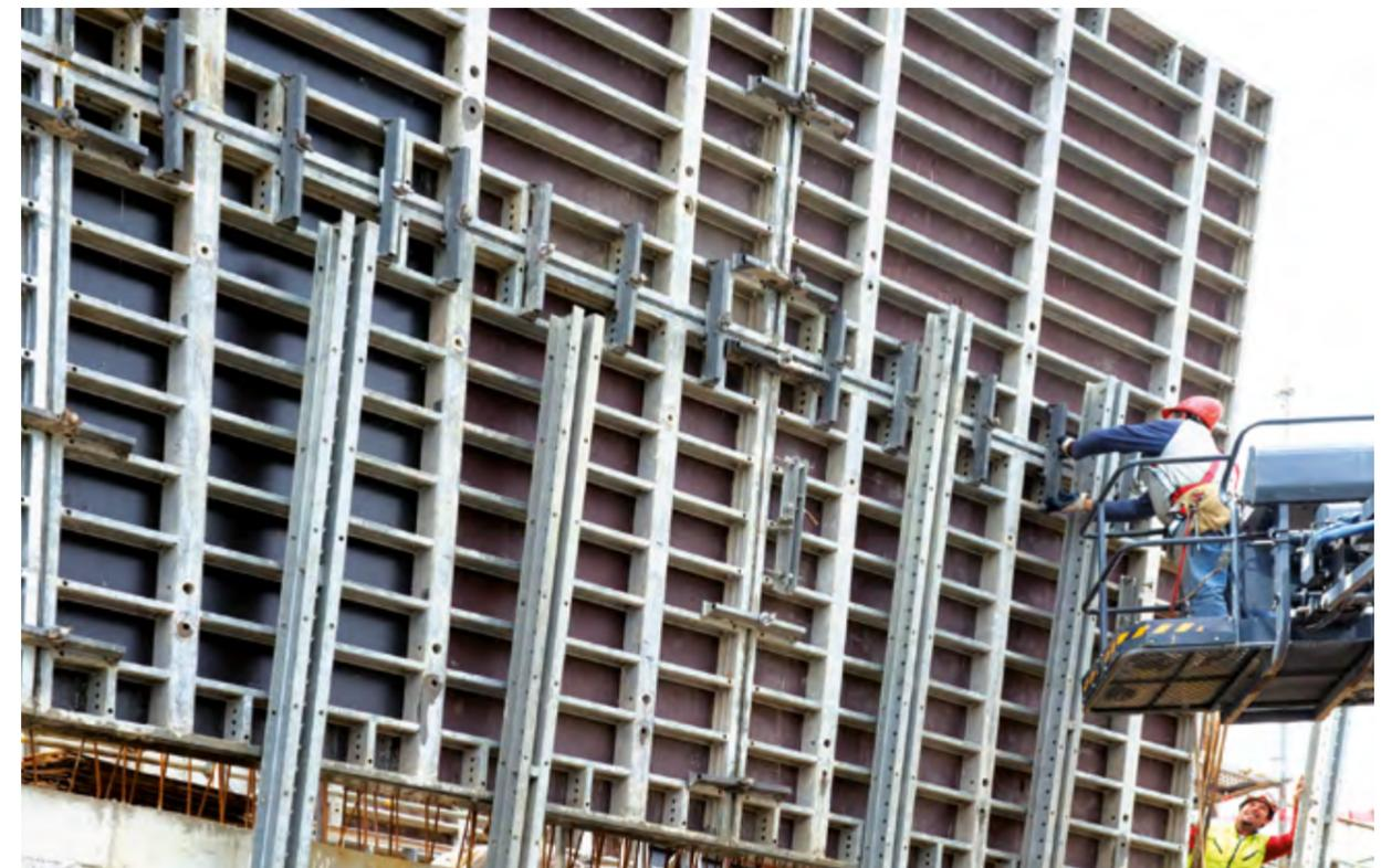
► Sonderlösung: Fassadenriegel werden genutzt, um die MANTO Schalung sicher und exakt in der gewünschten Schräglage auszurichten
