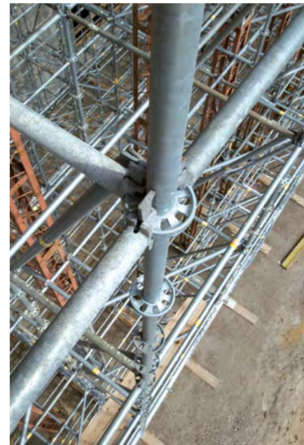
◀ Hoch flexibel dank der acht Anschlussmöglichkeiten in horizontaler, vertikaler und diagonaler Richtung
