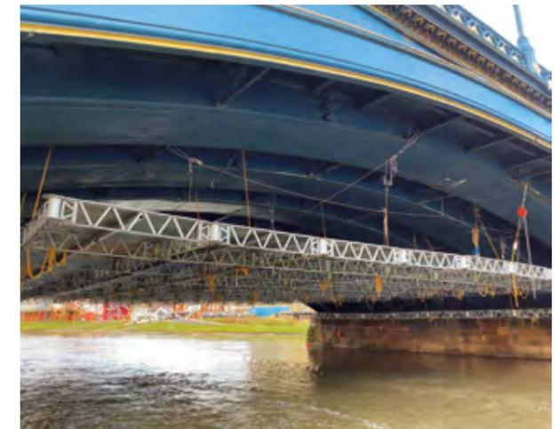
► QuikDeck bietet sichere und geräumige Arbeitsplattformen für Neubau-, Sanierungs- und Ausbesserungsarbeiten
