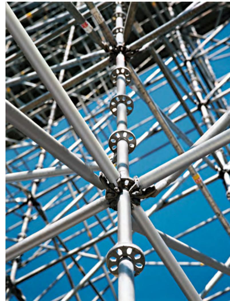
◀ Die Besonderheit des Systems beruht auf dem MODEX Kraftknotenprinzip. Im Raster von 50 cm sind auf den Vertikalstielen die sogenannten MODEX Teller angeordnet. Sie ermöglichen acht Anschlüsse in horizontaler und diagonaler Richtung. Die kraftschlüssigen Verbindungen können höchsten Belastungen standhalten.
