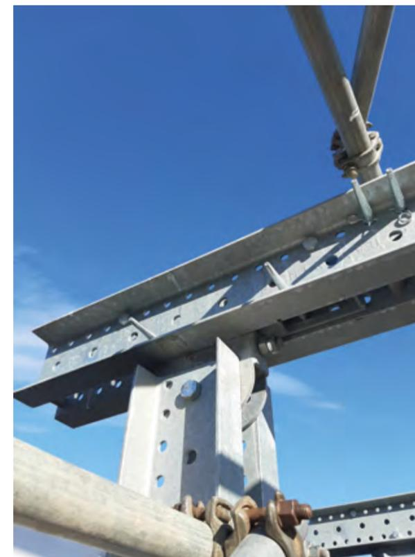
► Durchgängig gelochte U-Träger für den Einbau der Verbindungsmittel an jeder Stelle. So kann die Schalung in jedem gewünschten Winkel eingesetzt werden
