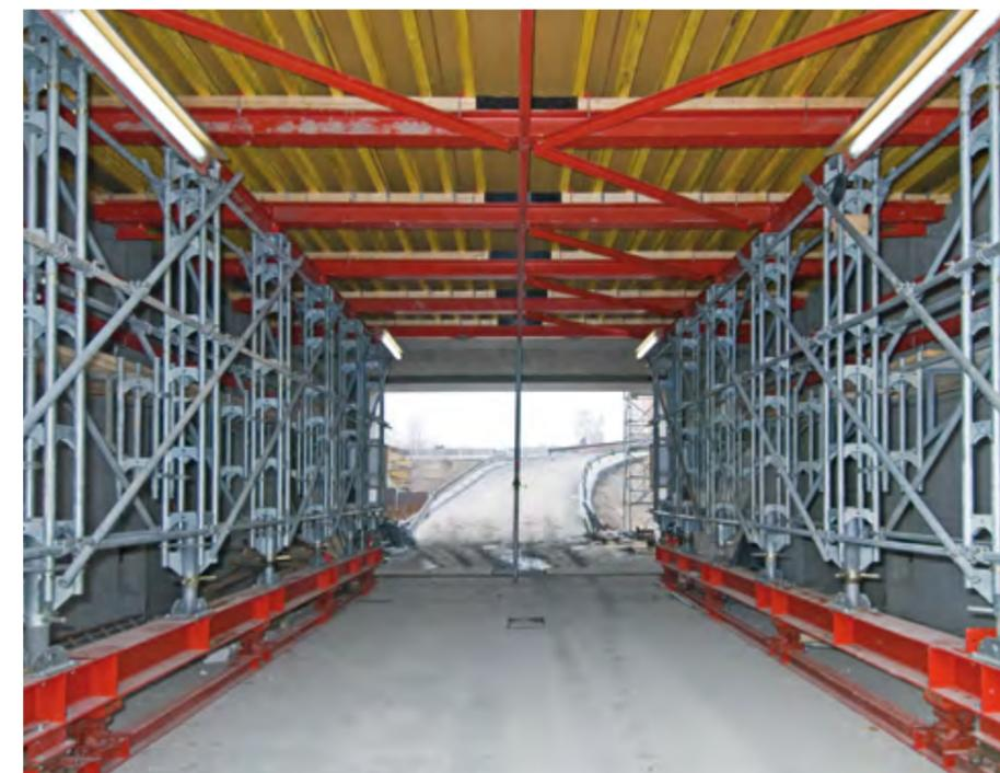
► Lastrahmenstütze als Traggerüstlösung für eine freie Baustellenunterführung
