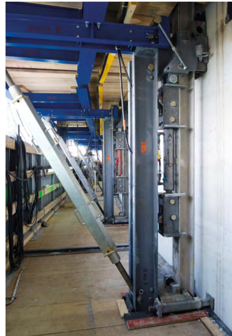
◀ Das Verhältnis von Konsolenzahl zu Schalungsfläche kann exakt der Gebäudegeometrie angepasst werden. Das Ergebnis sind kürzere Schalzeiten, weniger Arbeitsaufwand, mehr Effizienz.
