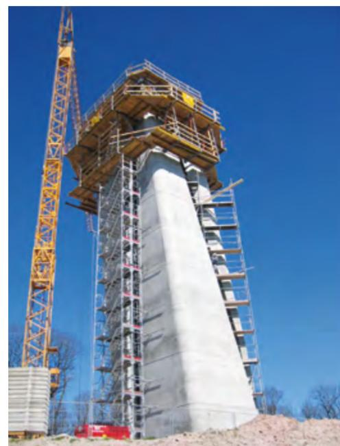
► Schalung kann vom Beton mittels einer Fahreinheit zurückgeschoben werden
