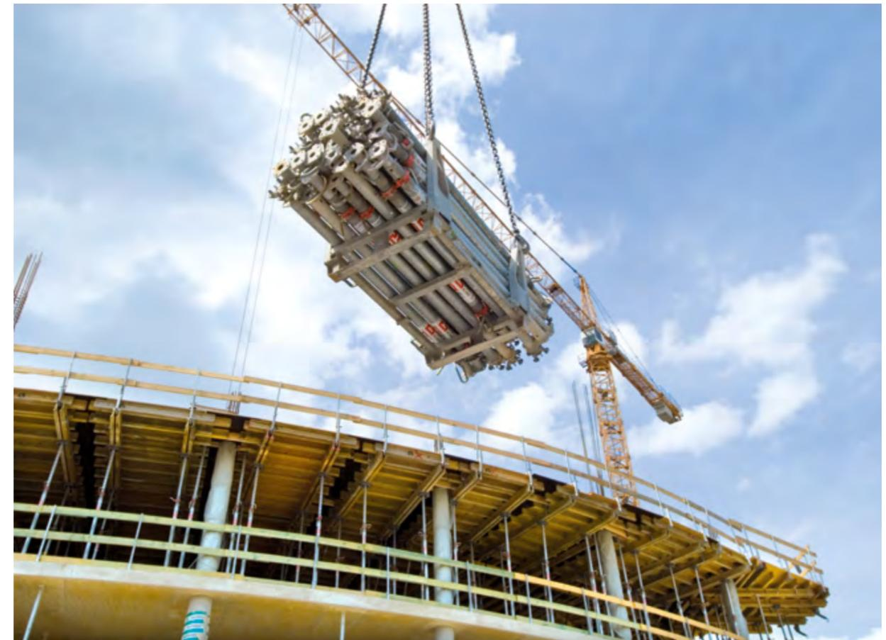
► Sicherer Transport der Stützen im Stapelgestell
