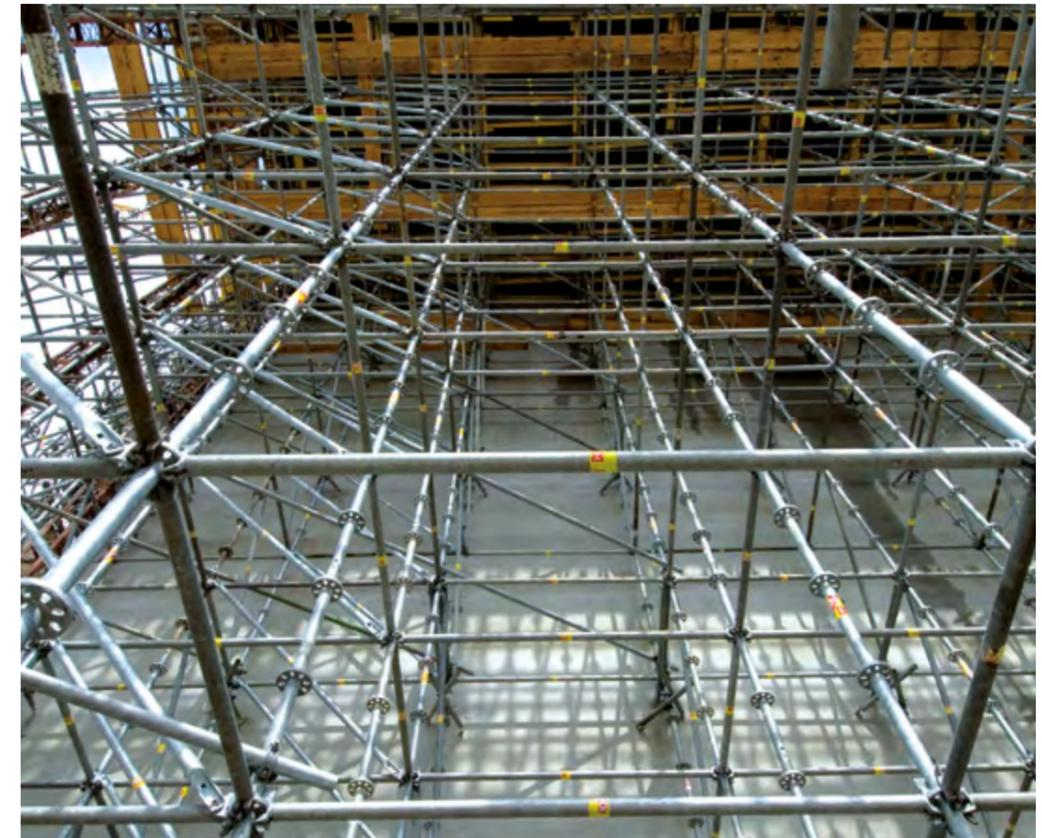
► Einfaches, variables Baukastensystem mit nur vier Grundelementen
