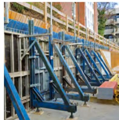
► Die Abstände zwischen den Stützböcken können je nach Bauplan angepasst werden
