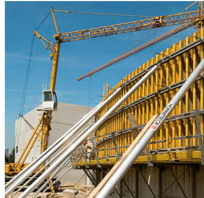
Die Super 10 ist eine Aluminiumstrebe, die sich besonders für große Anwendungen eignet. Ein weiterer Vorteil: Da der Gewindeteil der Hünnebeck Richtstreben mit einer Abdeckung geschützt ist, bleibt er stets sauber und leichtgängig und ist auch nach mehrfacher Verwendung immer einsatzbereit.
