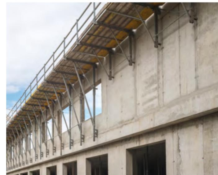
► Mit KG Hängestangen und KG Stützstreben lassen sich größere Wandöffnungen leicht überbrücken
