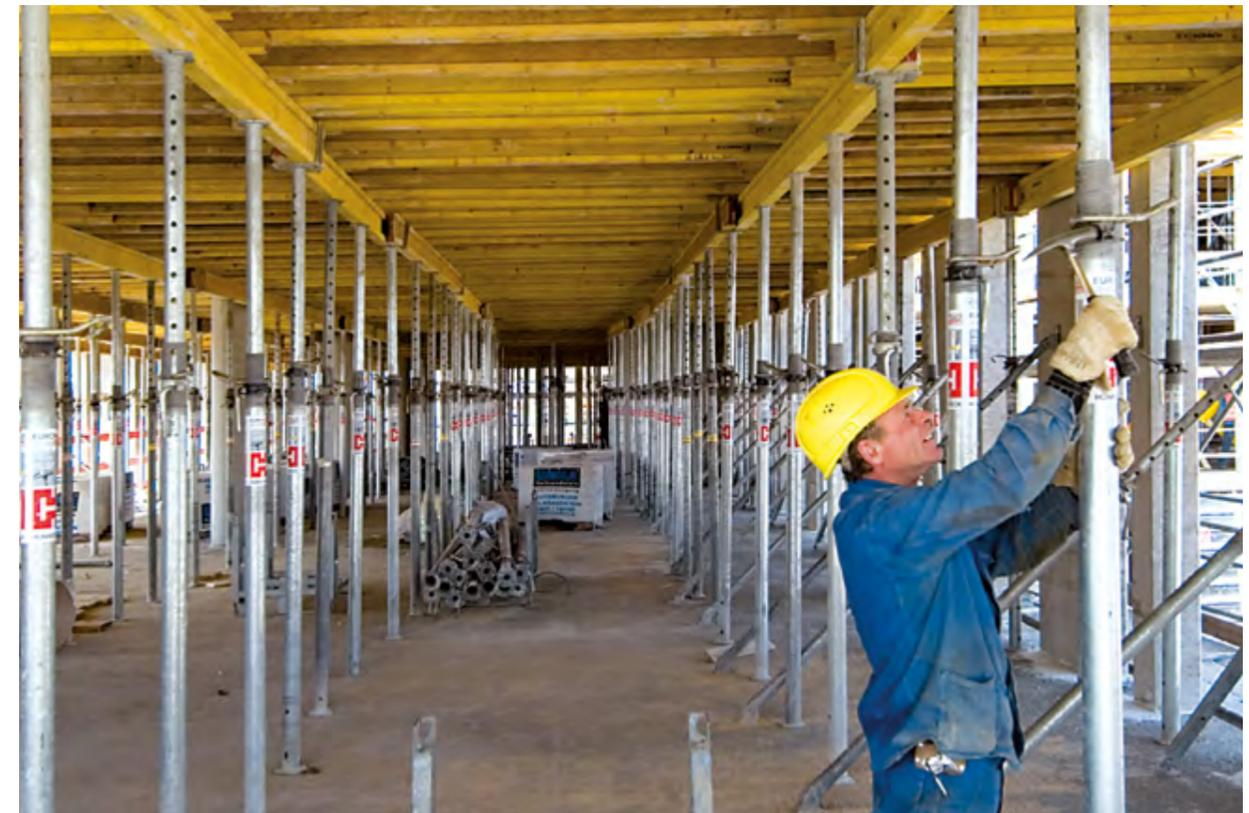
► Das Ausschalen wird durch ein Absenken der Schalungsebene um ca. 6 cm mithilfe der Einstellmutter der Stahlrohrstützen erleichtert
