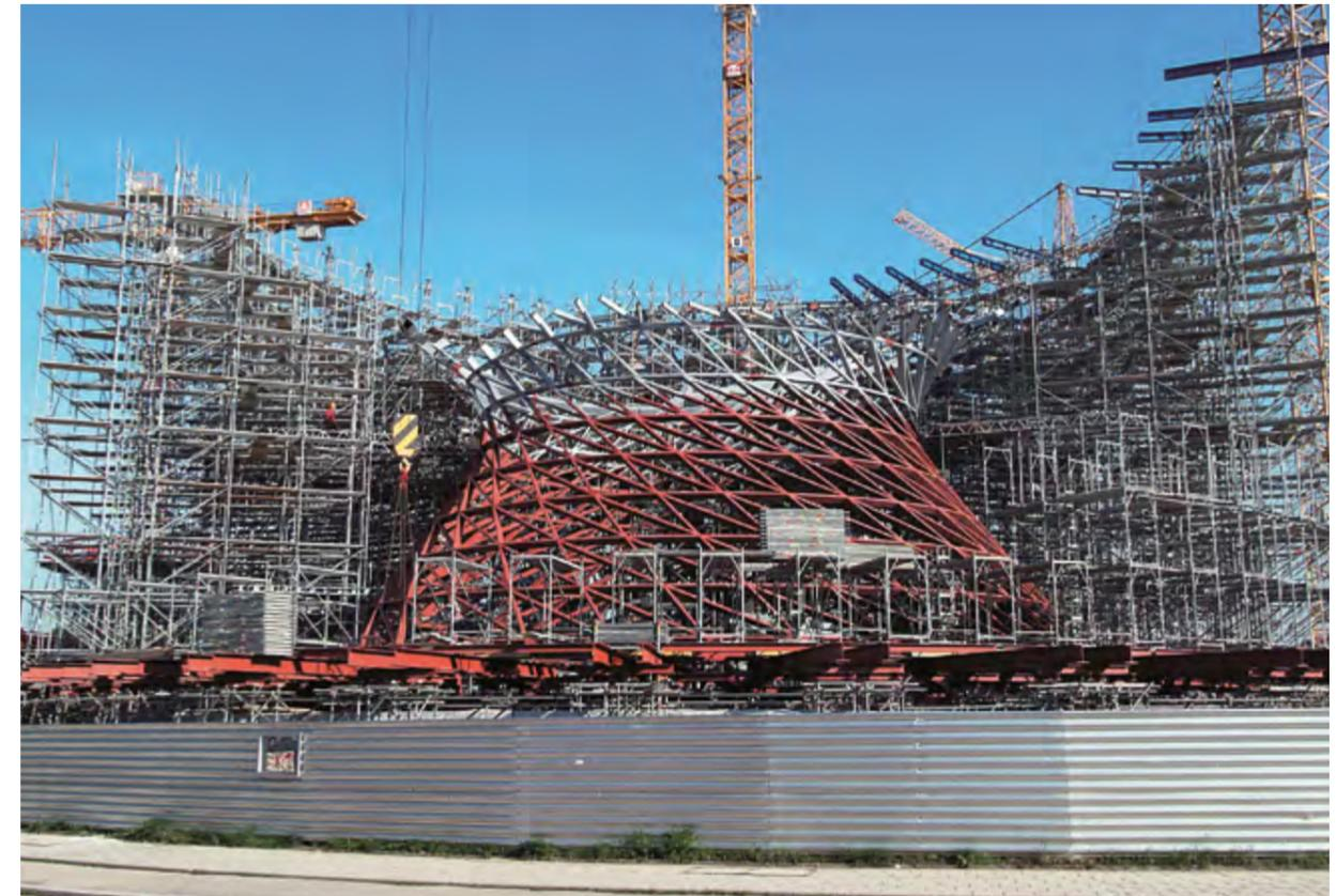
► BOSTA 70 ist mit MODEX einsetzbar. Hier ist es in Kombination zu einem sternförmigen Korsett kombiniert, das dazu dient, die hohen Lasten abzutragen
