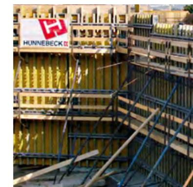
► Betondruckaufnahme bis zu 80 kN/m<sup>2</sup> möglich
