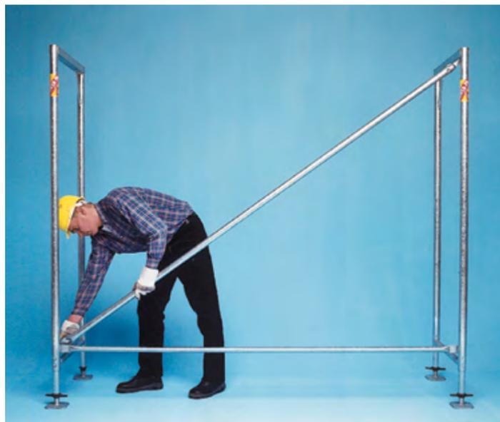
► Sicherer und zwangsläufig lotrechter Aufbau nach Erstellen des ersten Gerüstfeldes
