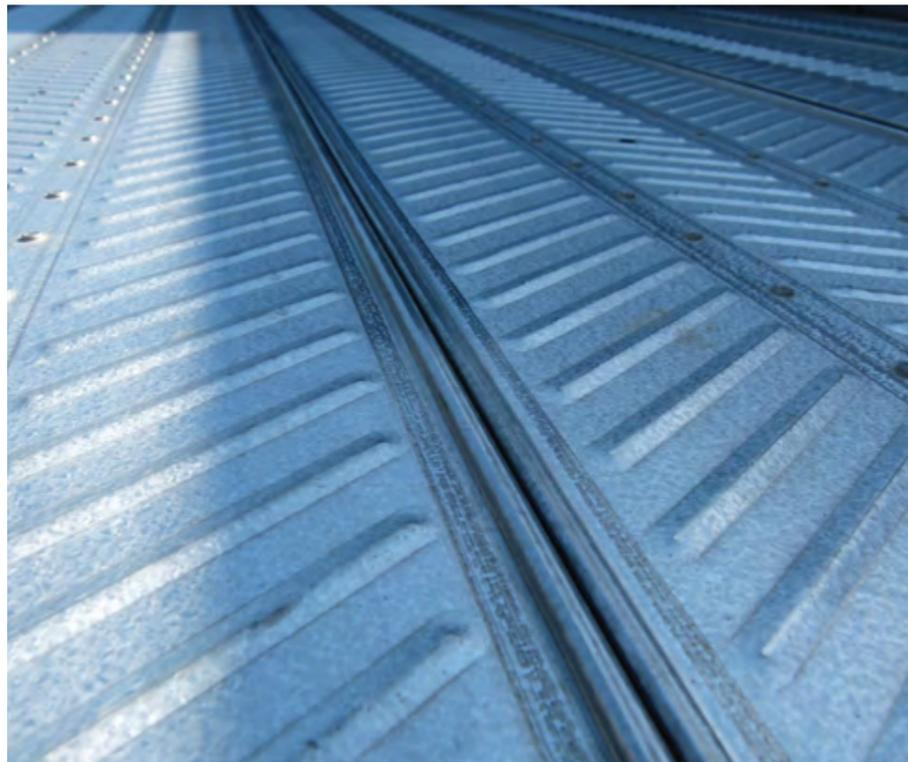
► Zusätzliche Sicherheit dank der strukturierten Oberfläche der Beläge, die auch bei Nässe die nötige Rutschsicherheit bietet
