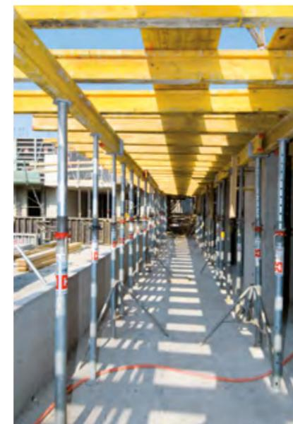
► Optimale Stützenanordnung für die auftretenden Lasten durch variable Stützenabstände
