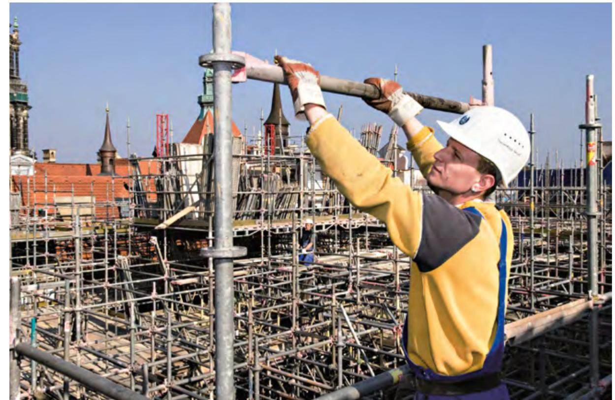
► Sichere Ein-Mann-Montage in jeder Höhe dank der aufgekanteten MODEX Teller
