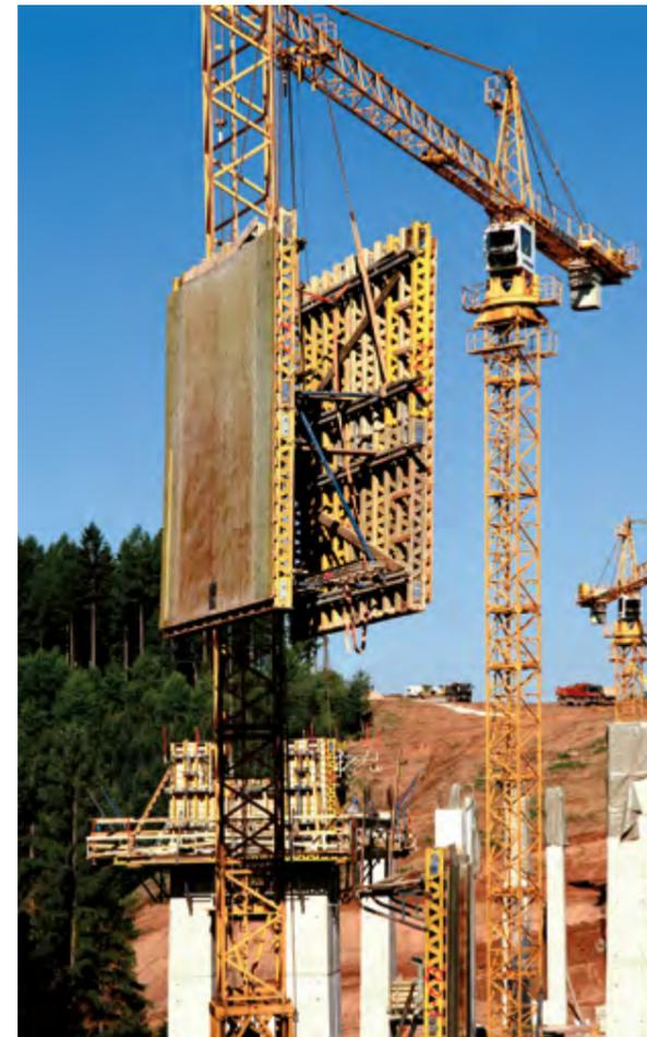
► Einfache Montage und Demontage ermöglicht problemlosen Umbau der Schaleinheiten bei häufigem Grundrisswechsel
