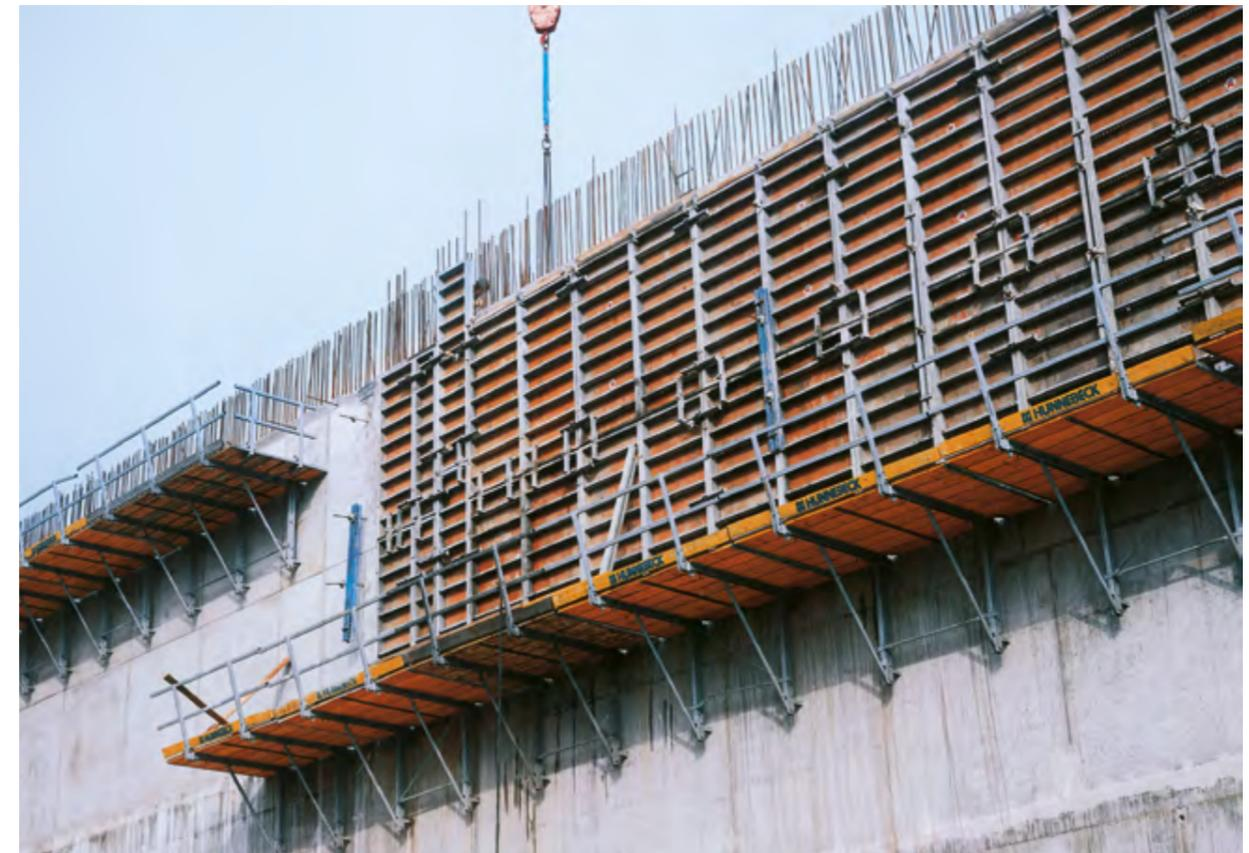
► Als Arbeitsgerüst trägt das Klappgerüst eine Nutzlast von  $2,0 \text{ kN/m}^2$  mit einer  $5,40 \text{ m}$  hohen Schalung bzw.  $6,0 \text{ kN/m}^2$  ohne Schalung
