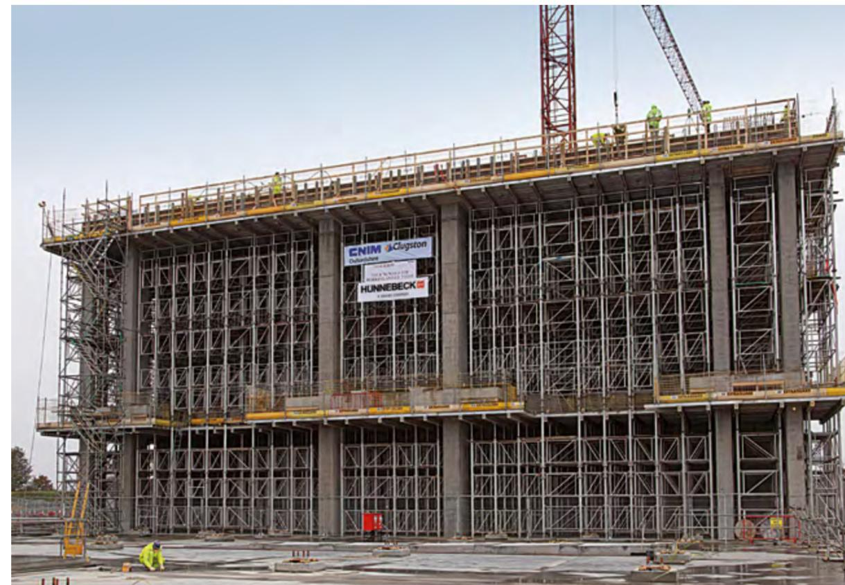
► Dank der hohen Tragfähigkeit von bis zu 140 kN pro Stiel sind nur wenige Bauteile erforderlich
