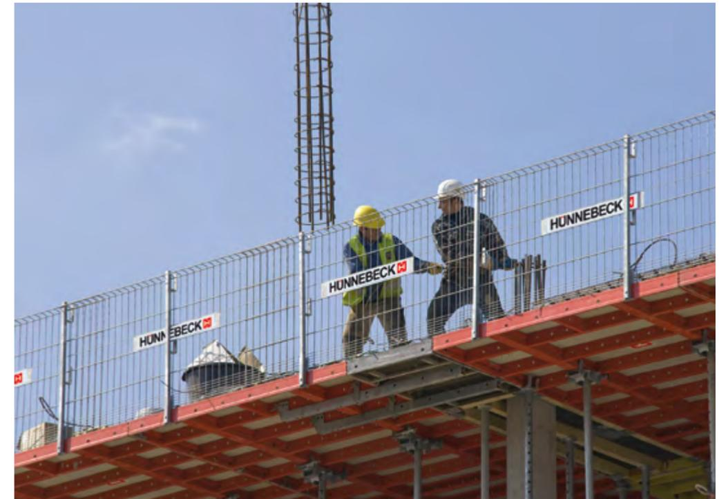
► PROTECTO ist mit allen Hünnebeck Deckenschalungssystemen, wie zum Beispiel dem hier abgebildeten TOPMAX, einsetzbar
