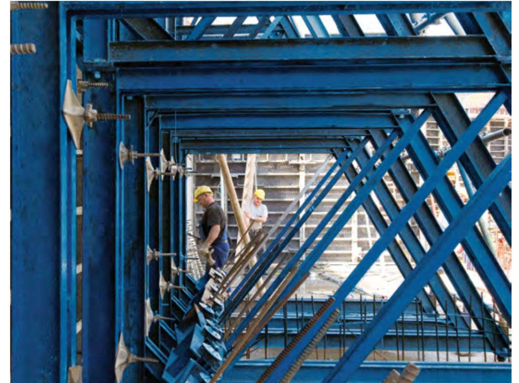
► Hohe Festigkeit: Stützböcke halten einem maximalen Betondruck von bis zu  $60 \text{ kN/m}^2$  stand
