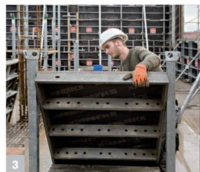
3 Montage sans grue grâce au faible poids des panneaux de base RASTO et TAKKO
