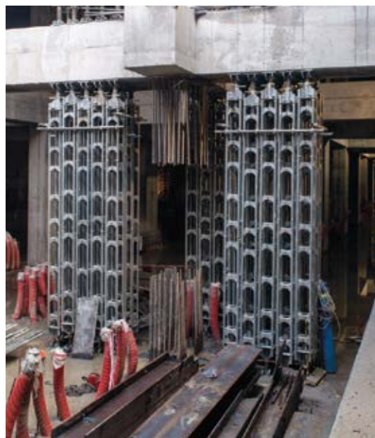
► Bardzo duża nośność do 200 kN na podporę mimo niewielkich wymiarów podstawy 25 x 25 cm
