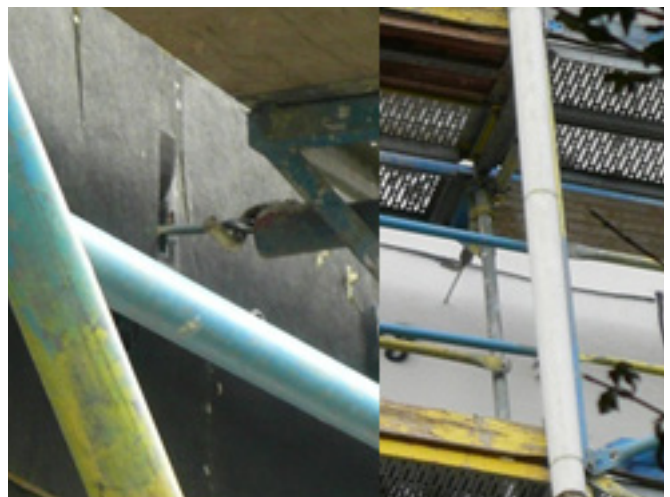
Herkömmliche Verankerung / Standard anchoring
