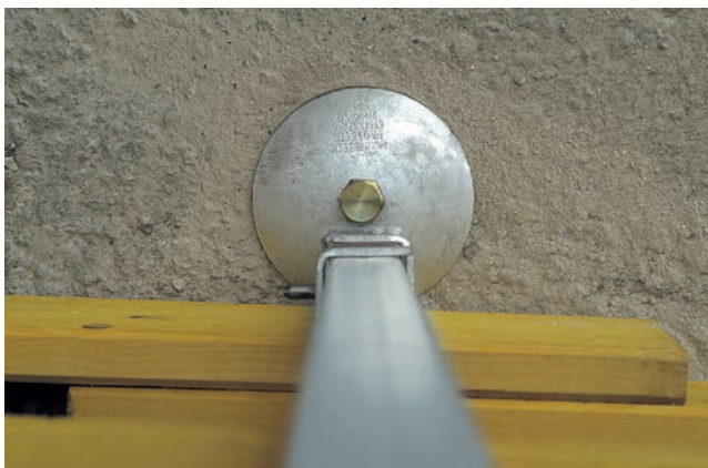
► De schroefvoet kan eenvoudig op de betonnen vloer worden bevestigd
