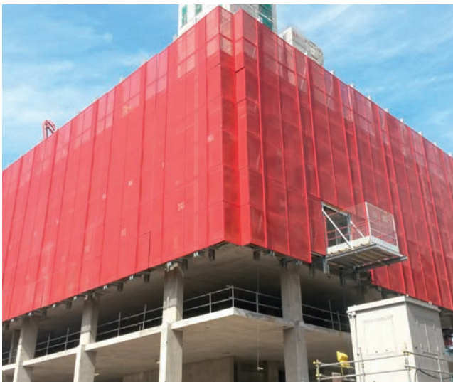
► Beveiligingsscherm voor medewerkers die op hoogte werken
