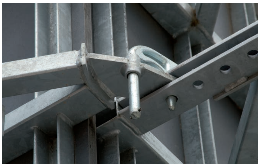
► Aanpassing van kolomdoorsneden in stappen van 5 cm
