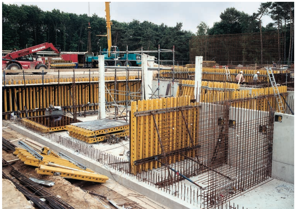
► Vrije keus van bekistingsplaat afhankelijk van de kwaliteitseisen aan het betonoppervlak
