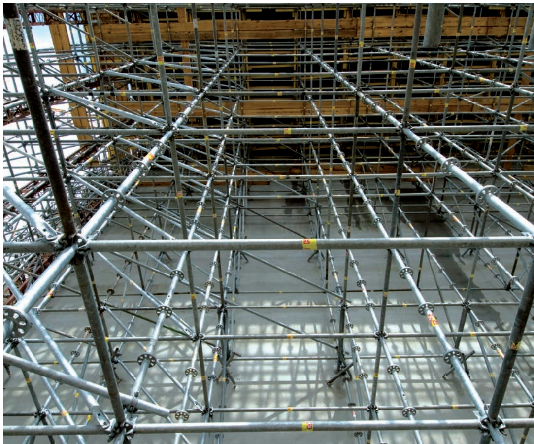
► Eenvoudig, variabel modulair systeem met slechts vier basisonderdelen.
