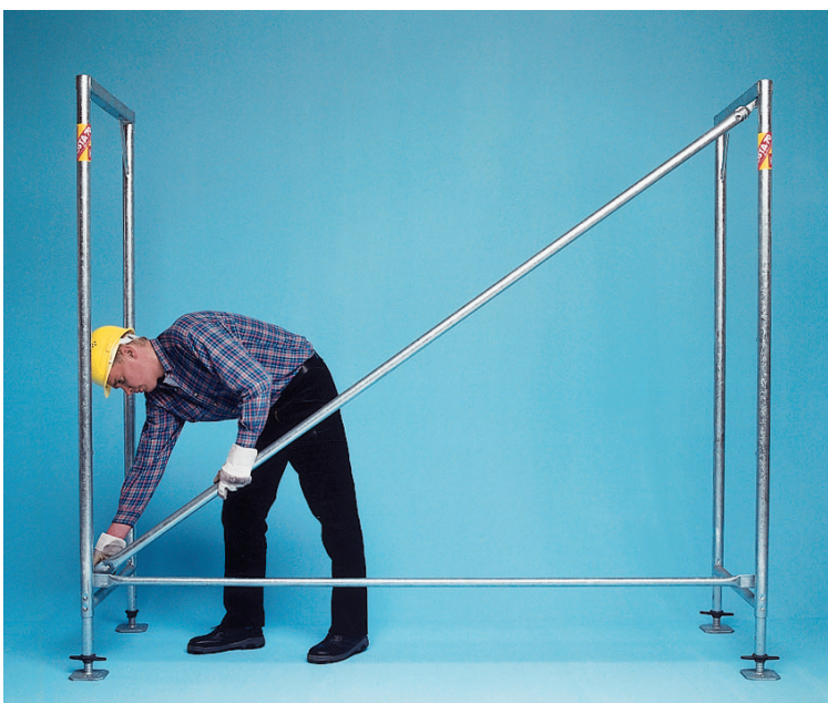
► Veiliger en automatisch loodrecht opbouwen na het opstellen van het eerste steigerveld
