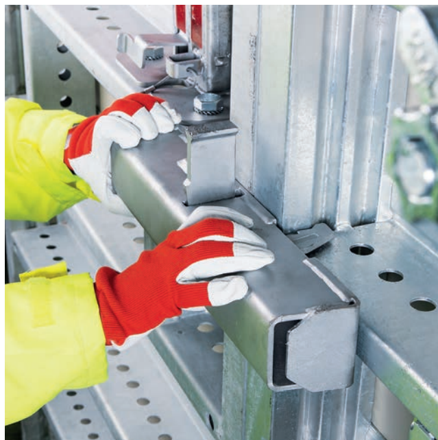
► Eenvoudige en snelle paneelverbinding door het wig-richtslot
