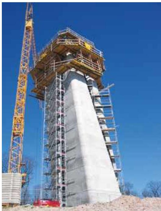
► El encofrado puede retirarse del hormigon mediante una unidad de separación.
