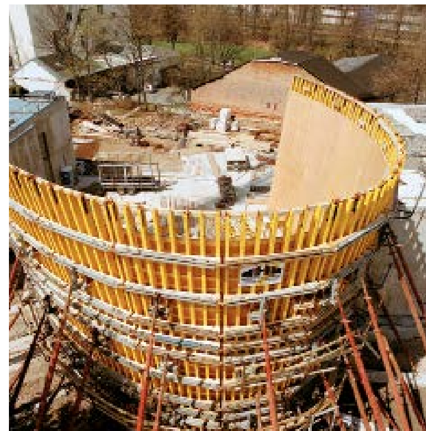
► Łatwy dobór wysokości elementów do wymagań powierzchni betonowej
