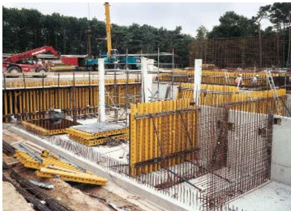
► Szeroki wybór sklejki ułatwia uzyskanie wymaganej jakości powierzchni betonu
