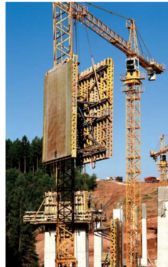
► Łatwy montaż i demontaż jednostek szalunkowych umożliwia bezproblemową modernizację przy częstych zmianach geometrii
