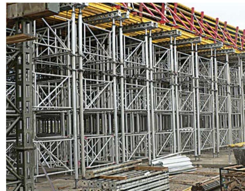
► Rusztowanie podpierające deskowanie mostu
