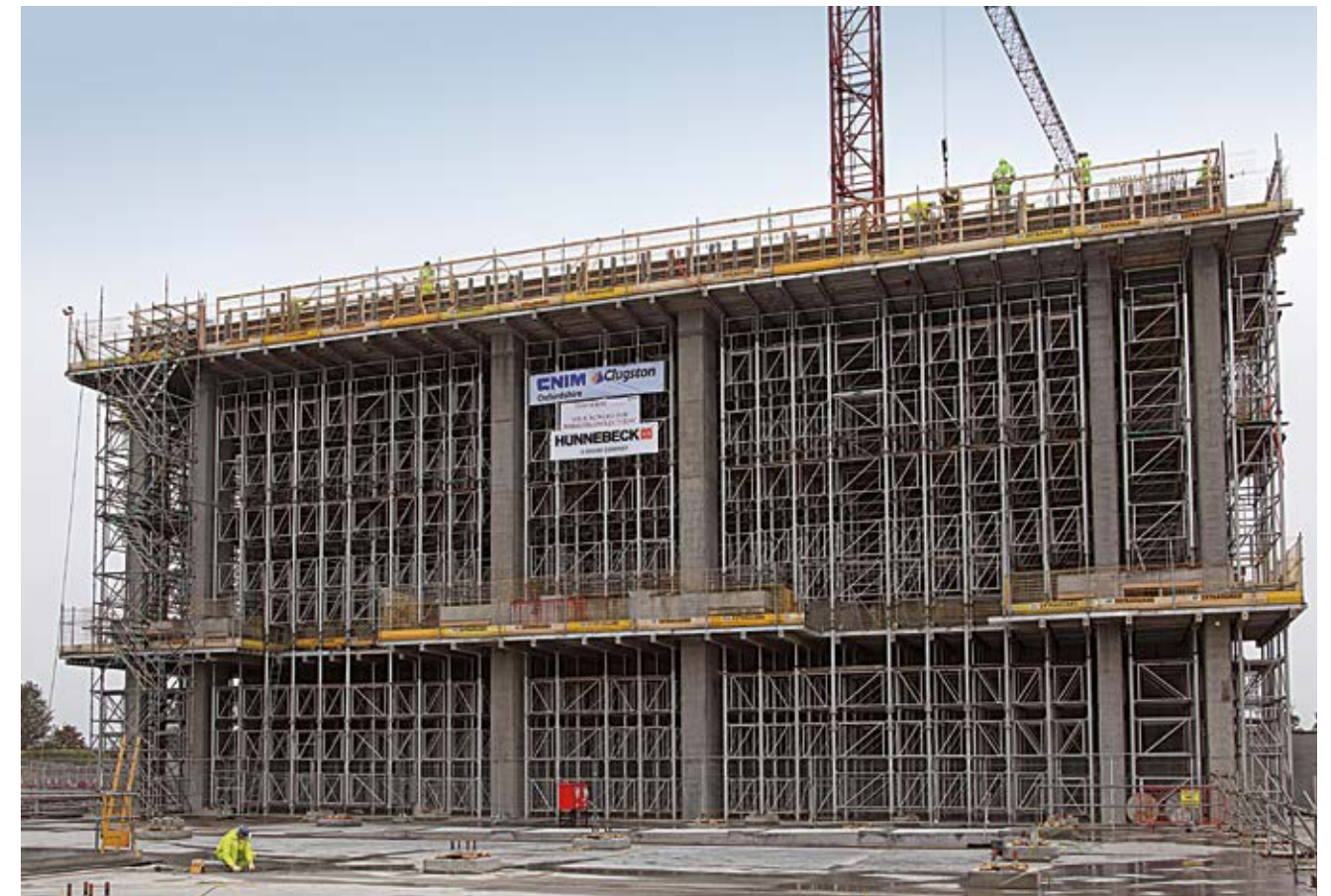
► Przenoszenie obciążeń do 140 kN zmniejsza ilość potrzebnego sprzętu
