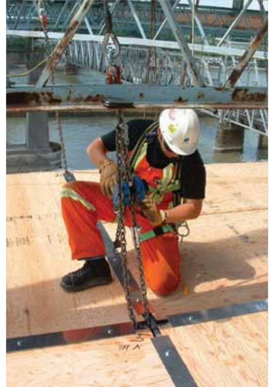
realizar el trabajo. Dependiendo de la configuración y de la separación entre los dispositivos de suspensión, las capacidades de carga pueden variar de 25 a más de 75 libras por pie cuadrado (pounds per square foot, psf). Todos los componentes de acero estructural son galvanizados por inmersión en caliente para mantener la clasificación de carga total y una larga vida de servicio. Este exclusivo sistema de acceso obtiene su resistencia de los miembros estructurales de acero, no de cables.
