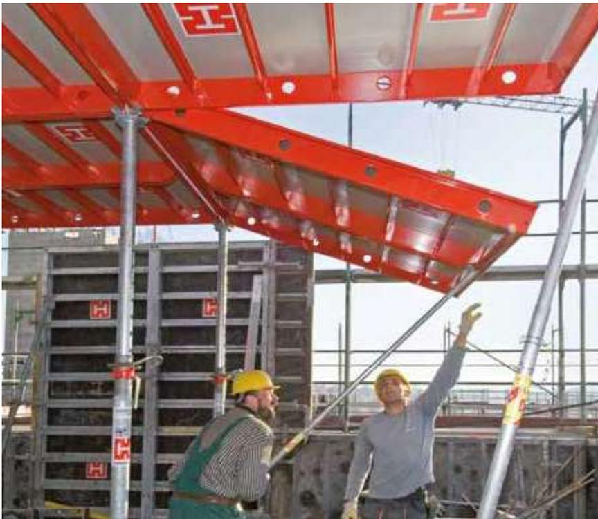
◀ Montaje y desmontaje seguro con solo tres pasos: Enganchar, levantar y apuntalar.
