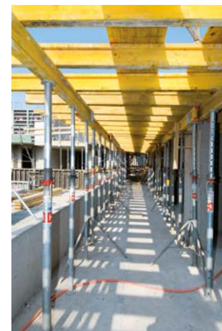
► Optymalny układ podparć obciążenia dzięki regulacji rozstawu podpór
