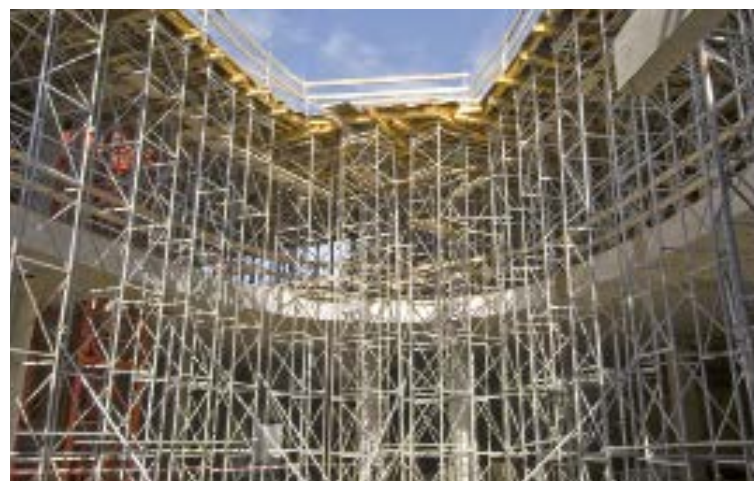
► Wszechstronny system do szalowania stropów o dowolnej geometrii i grubości płyty
