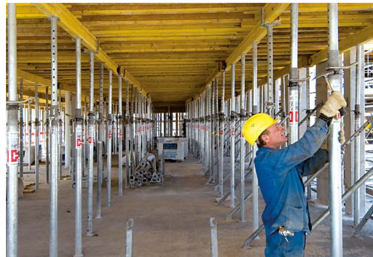
► Uprozczone rozszalowanie dzięki nakrętce regulacyjnej podpór stalowych
