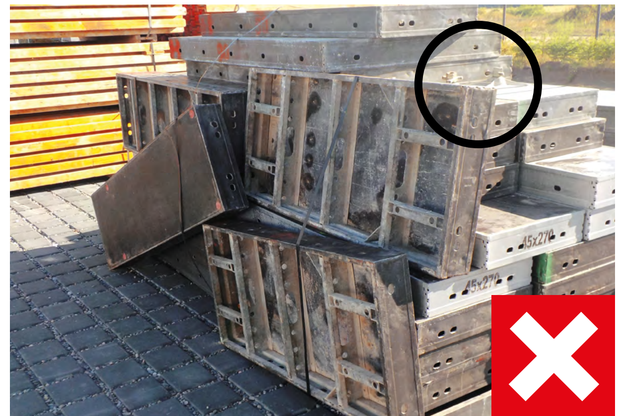
Figuur 16 Onjuiste bundeling van materiaal: Verschillende maten RASTO- en TAKKO-platen werden verticaal en horizontaal in elkaar gestapeld. Bovendien zitten er losse accessoires op de bekisting.
