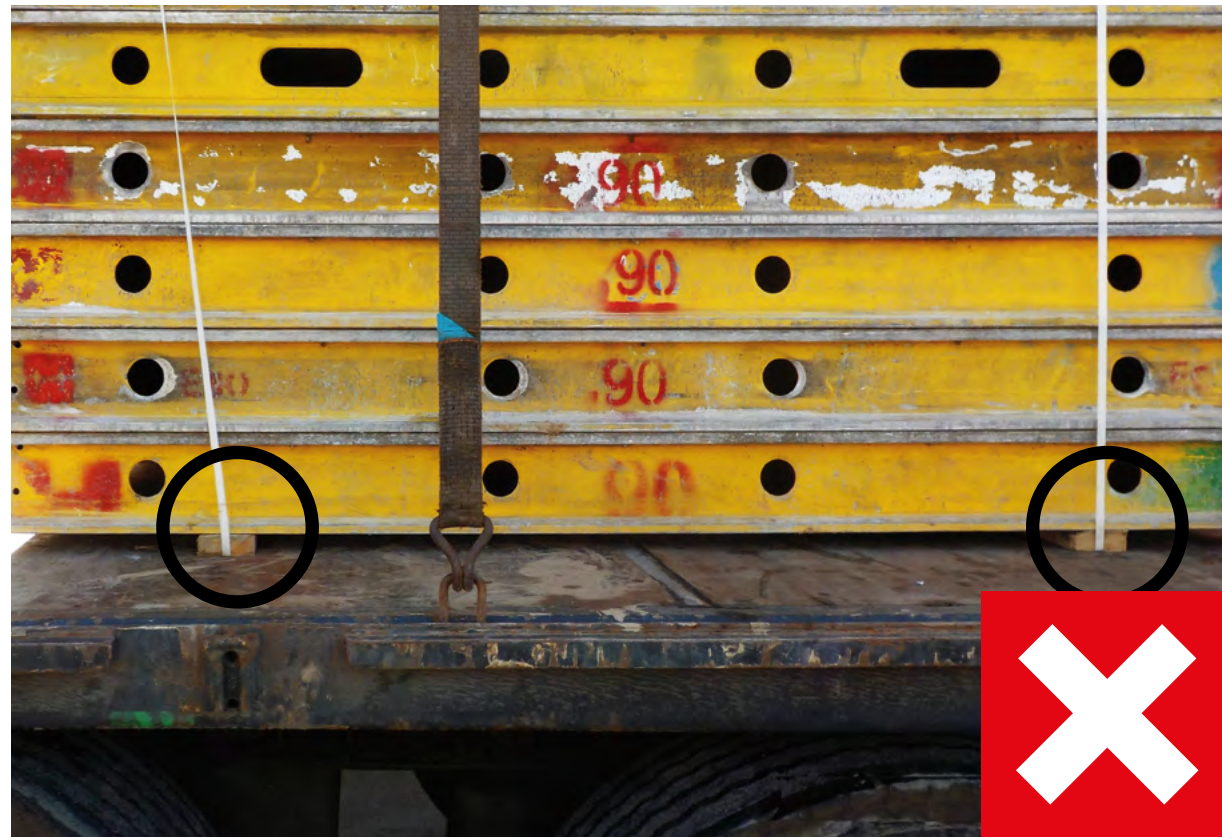
Figuur 13 Onjuist voorbereid transport: Het stuwhout is te laag, zodat een vorkheftruck er niet onder kan om de lading te lossen.
