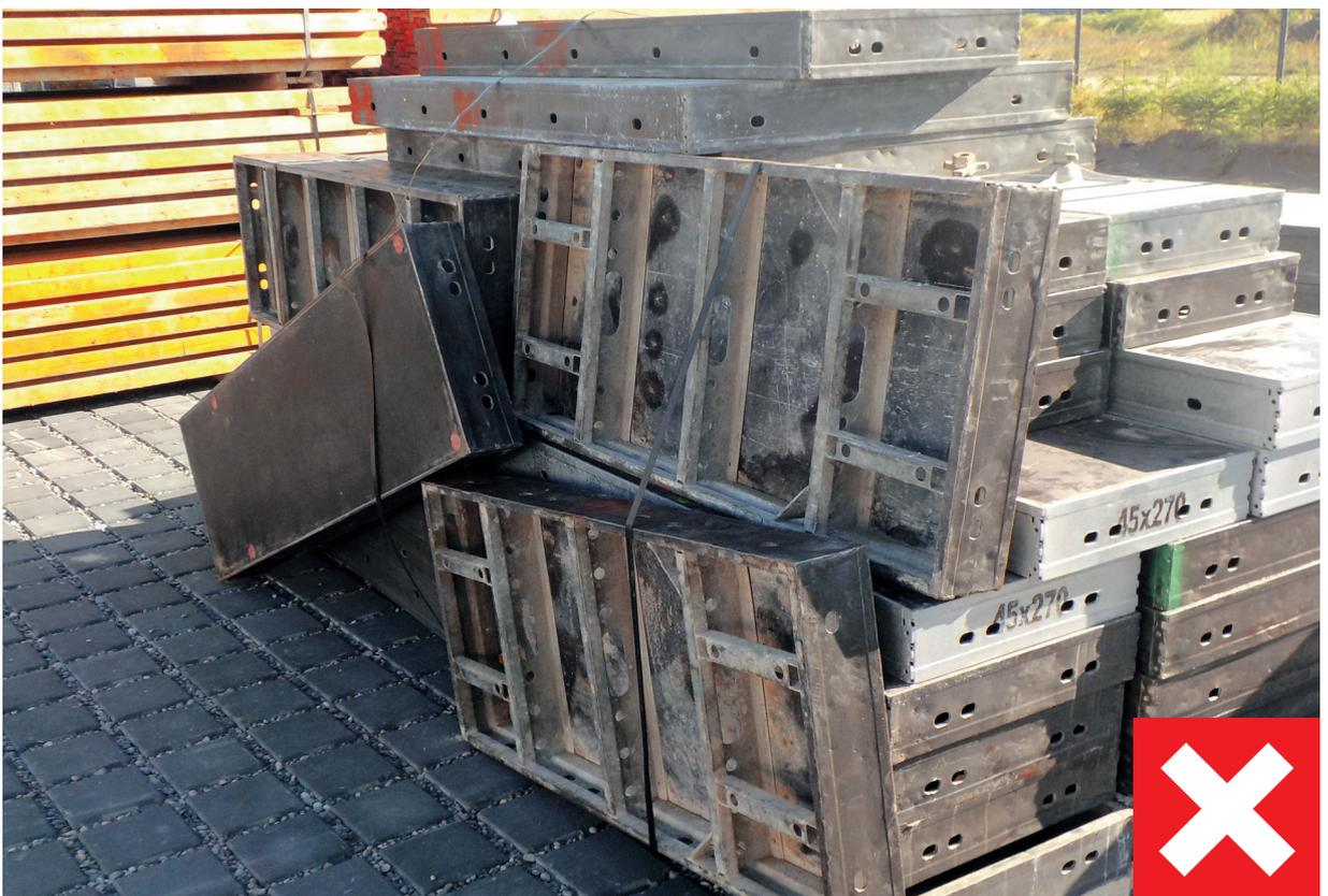
Falsche Materialbündelung: Unterschiedliche Größen von RASTO® und TAKKO® Tafeln wurden senkrecht und waagrecht ineinander gestapelt. Zusätzlich befinden sich lose Zubehörteile auf der Schalung.
